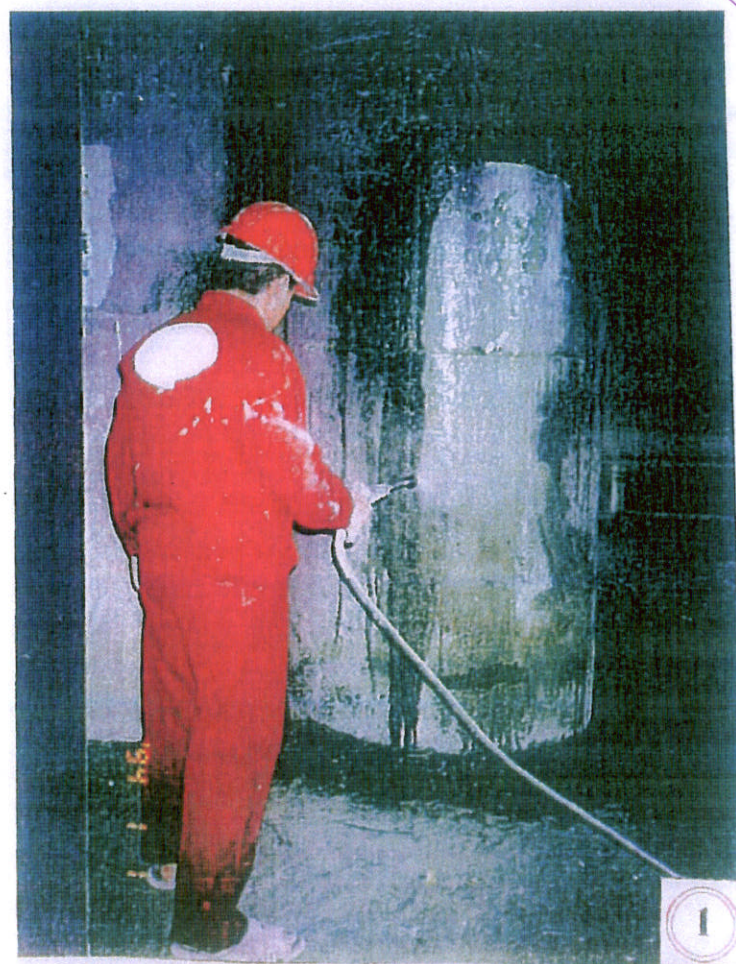
CURĂȚAREA SUPRAFEȚELOR DIN BETON
