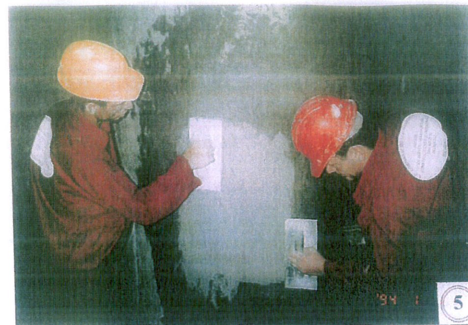
FINISARE MORTAR DE REPARAȚII APLICAT
