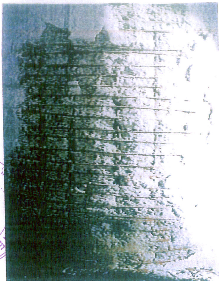
ÎNDEPĂRTAREA MECANICĂ/MANUALĂ A BETONULUI DEGRADAT
