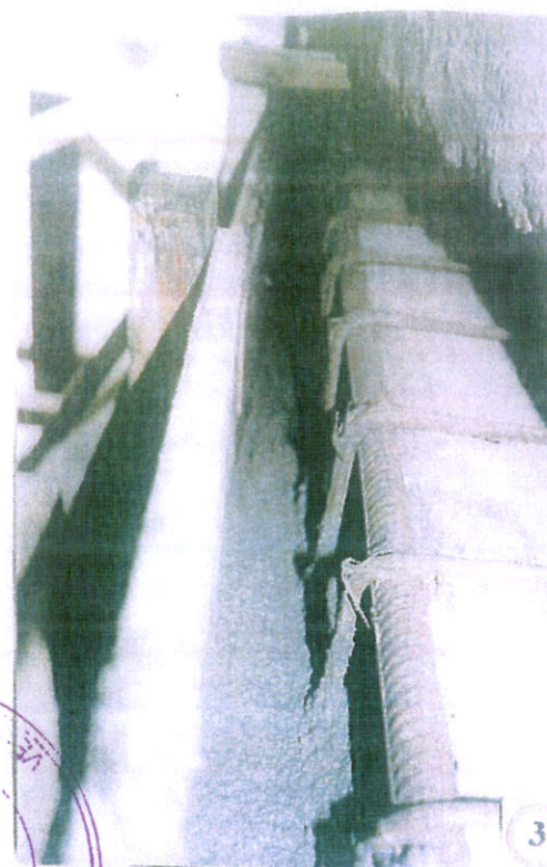
APLICARE MATERIAL SUPERFLUID ÎN COFRAJ ETANȘ
