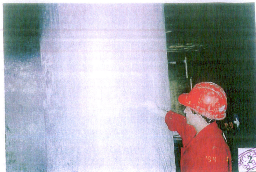
MARCAREA SUPRAFEȚELOR DEGRADATE
